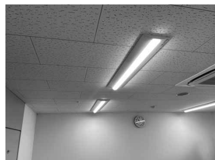
照明LED化工事
