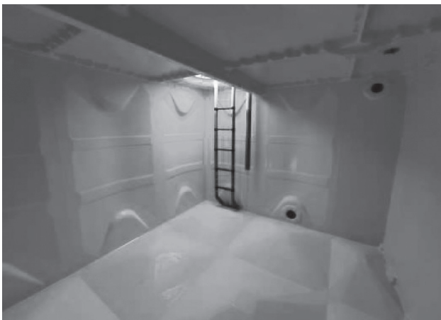
高架槽ポリウレア止水工事
